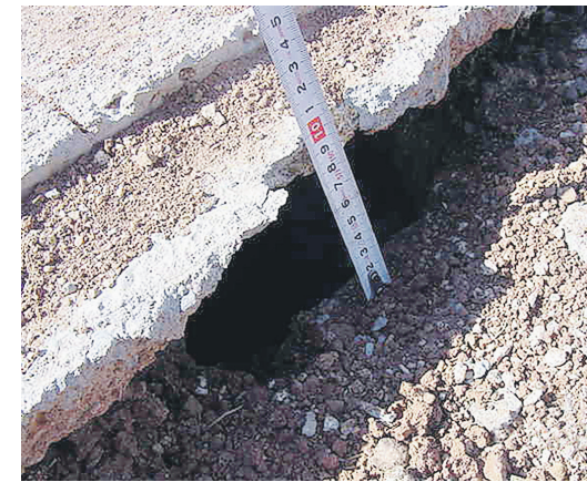
La falta de apoyo en los bordes de un camino pueden deberse a un proceso de compactación inadecuado, incorrecto o con fallas.
